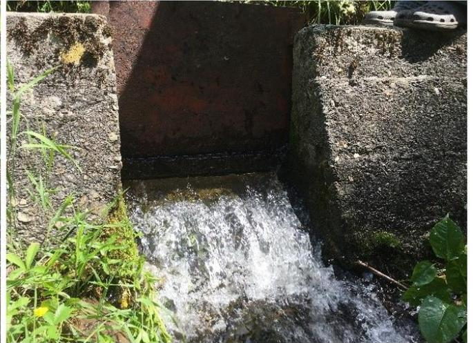
Batardeau (à gauche) et vanne de restitution (à droite) avec une ouverture de 5 cm
