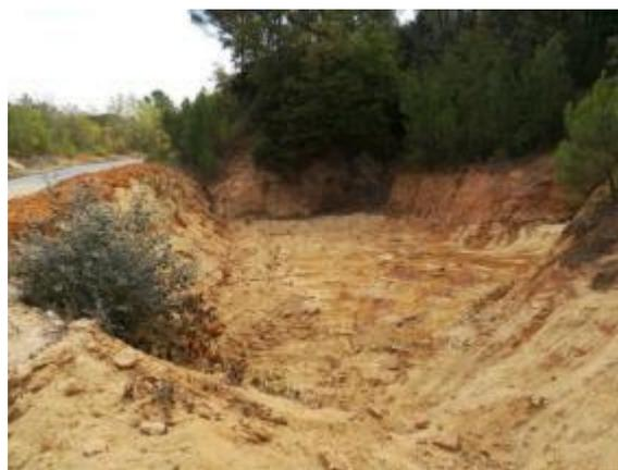
*Banquettes créées sur le site d'exploitation des Sables / bassin de décantations curé, avant l'arrivée dans le cours d'eau*
