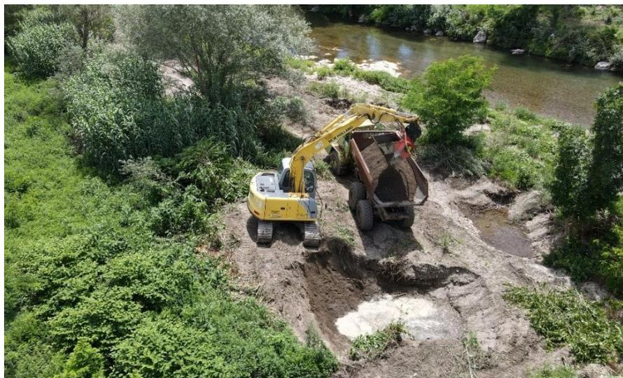
*Photo sur la réalisation des travaux : broyage de rhizomes sur une matte vulnérable aux crues du Gardon*
