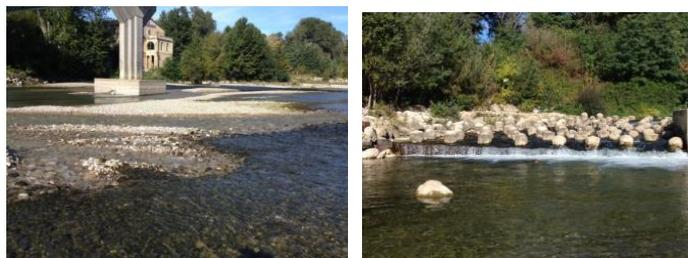
*Mise en mouvement des matériaux sous le pont routier - Chute d'eau en pied de passe à poissons*
