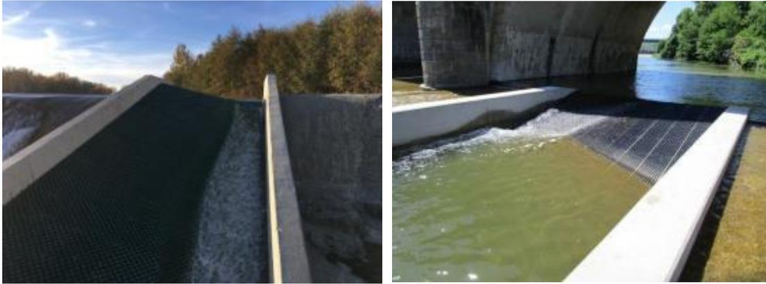
*Seuil de Saint Chaptès équipé et passe à anguille du radier du pont routier et ferroviaire à Ners*
