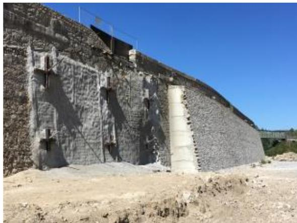
*Travaux de confortement – micropieux et épaulement maçonné*
