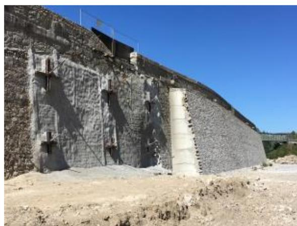
*Travaux de confortement – micropieux et épaulement maçonné*
