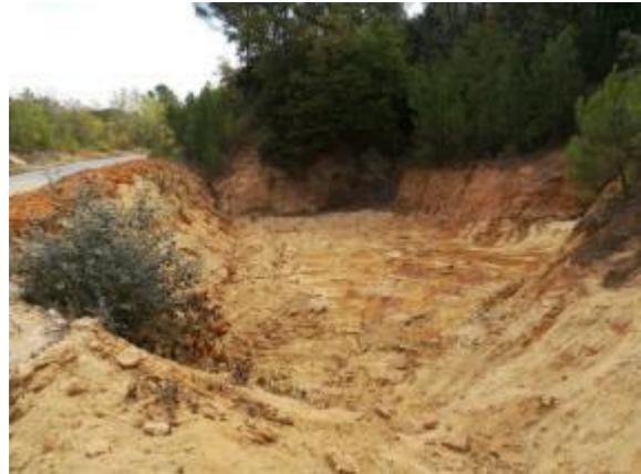
Banquettes créées sur le site d'exploitation des Sables / bassin de décantations curé, avant l'arrivée dans le cours d'eau
