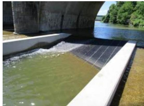
*Seuil de Saint Chaptès équipé et passe à anguille du radier du pont routier et ferroviaire à Ners*
