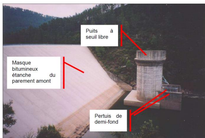
Photo 1 : Vue des parements amont et de la tulipe du barrage de Sainte Cécile
