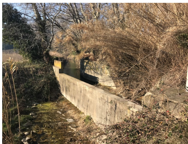
Figure 8 : Vanne et déversoir de la Palud
