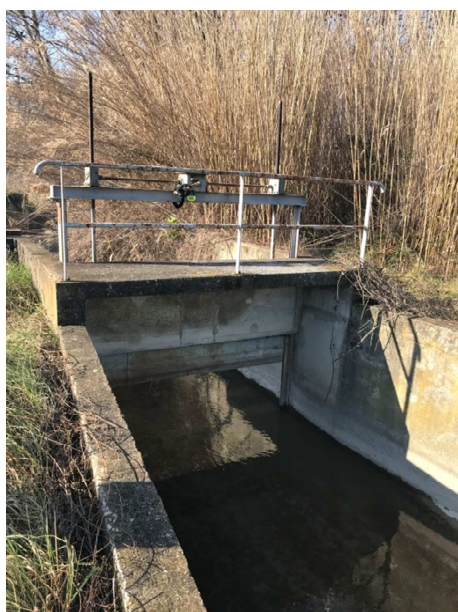
Figure 8 : Vanne et déversoir de la Palud
