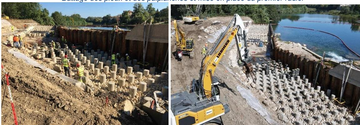
*Mise en place des menhirs et des blocs de fond de passe*
