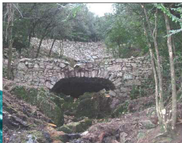
Photo 3 - Bassin-source sous voûte dans la partie inférieure du valat V2. (cliché : G. ROQUES)
