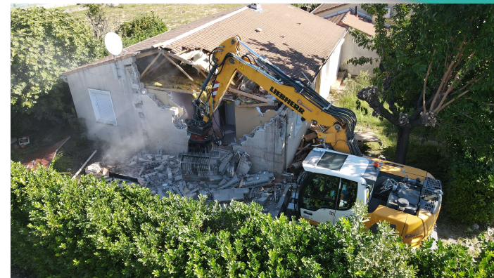
Démolition d'une maison Propriétaire relocalisé hors zone inondable
