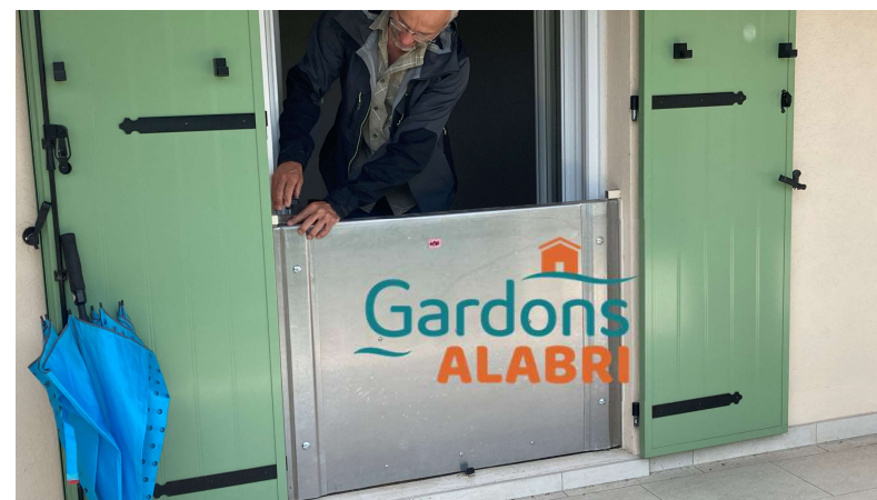
Pose d'un batardeau Opération Gardons ALABRI n°3
