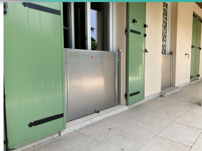
Maison équipée de batardeaux
