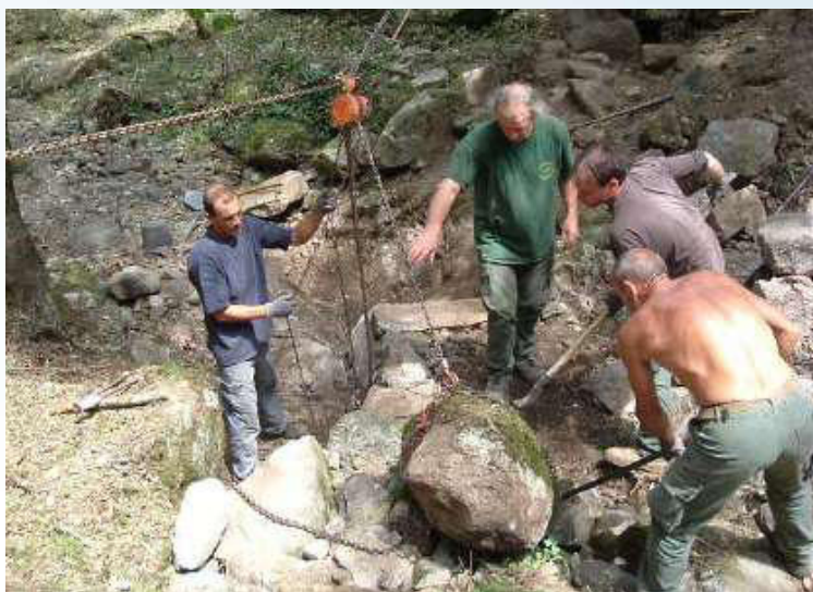
Photo 1 - Manipulation d'un bloc sur le chantier de réhabilitation des tancats . (cliché : J.F. DIDON- LESCOT)
