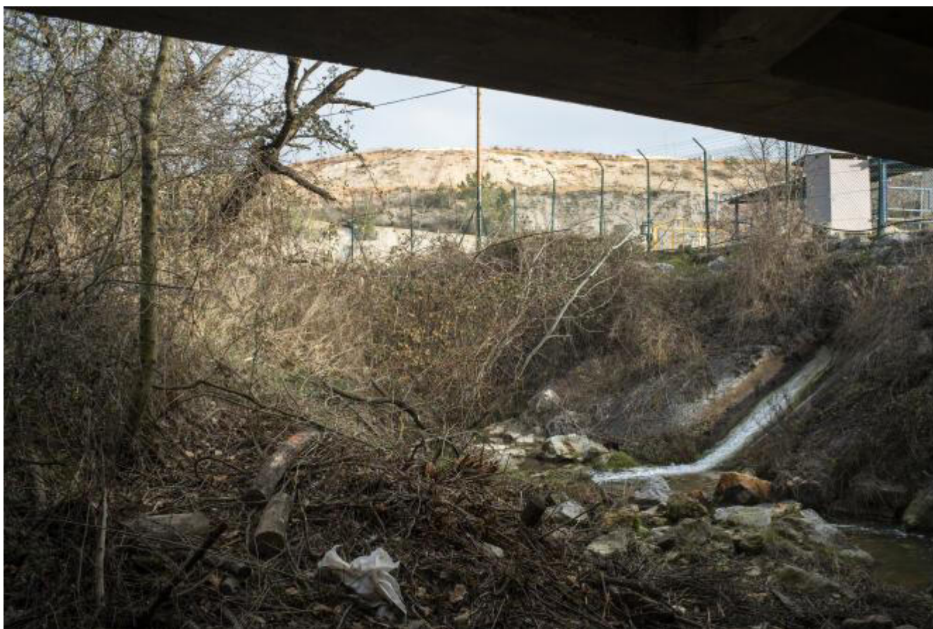
Le point de rejet de l'usine du groupe de chimie Solvay à Salindres (Gard), le 30 janvier 2024. JULIEN GOLDSTEIN POUR «LE MONDE»
