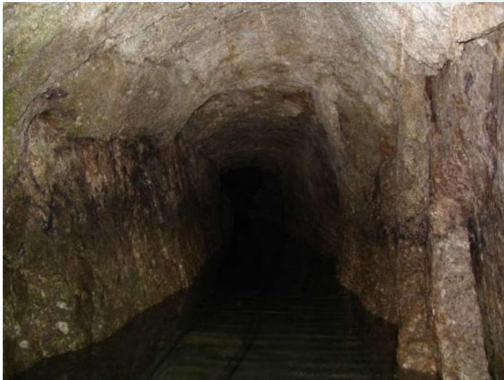
Exemple de galerie dans la rég. du Collet-de-Dèze, longueur 42 mètres. Le processus est pratiquement identique à celui du précédent exemple. La réserve intérieure est obtenue par une pierre scellée sur champ à proximité de l'entrée.
