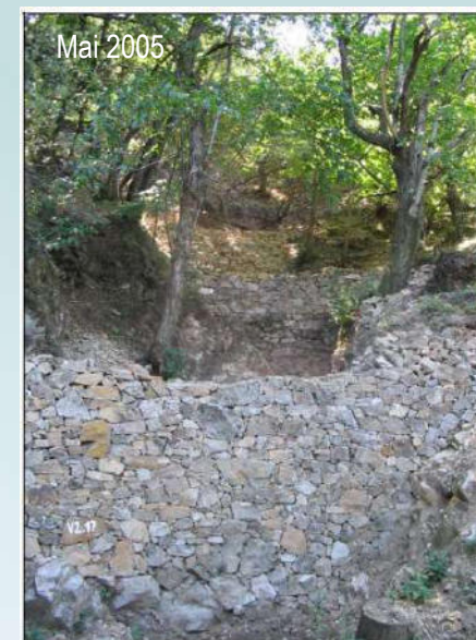
Réhabilitation de tancats dans la partie amont du vallon V2 entre mars et mai 2005. (clichés : G. ROQUES)
