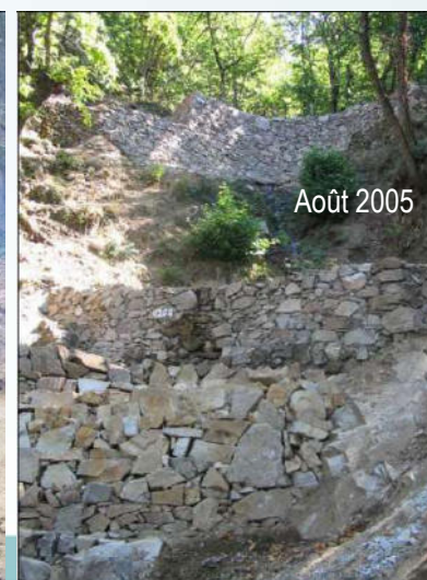
Réhabilitation de tancats dans la partie intermédiaire du vallon V2 entre mars et août 2005. (clichés : G. ROQUES)
