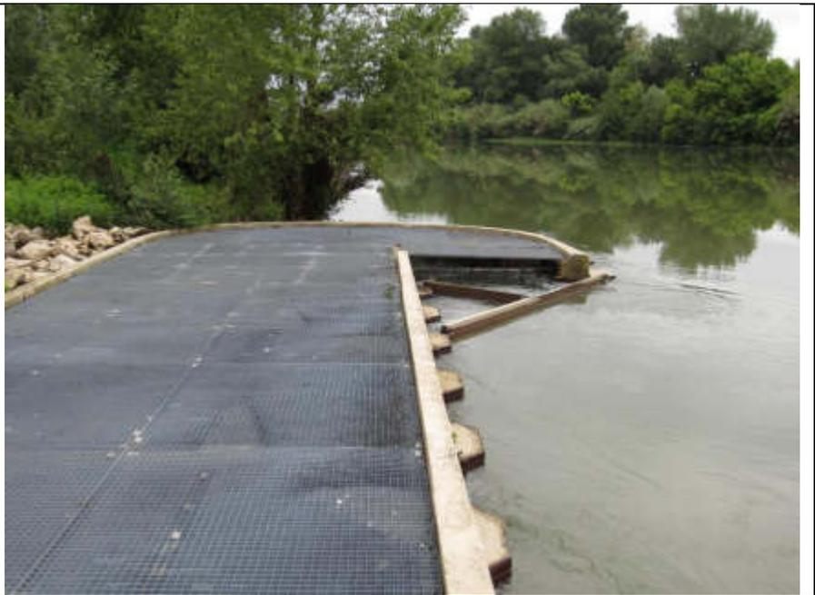
Dispositif de protection de la prise d'eau
