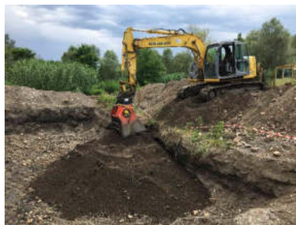
Broyage de la renouée du Japon dans une fosse hors crue à Alès en 2020
