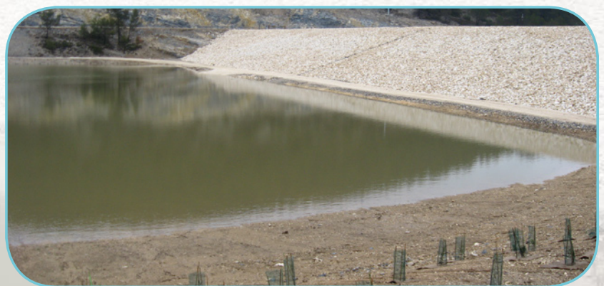
Mise en eau de l'ouvrage de surstockage
