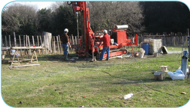
Reconnaissance géotechnique à Meynes
